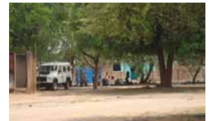
Krankenstation in Makalondi noch in desolatem Zustand
