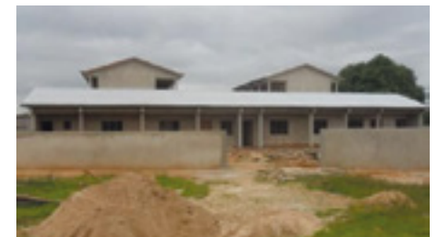
Bau des Schwesternhauses
