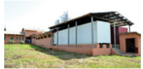
Der neu errichtete Hangar über dem OP-Container als Sonnenschutz und das Generator-Häuschen
