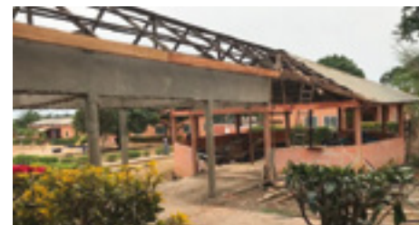
Bauarbeiten Kinderstation Gohomey
